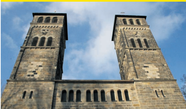
Die Dreifaltigkeitskirche in der Flurstraße 10, erbaut im Jahre 1900.
